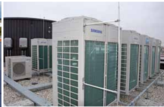
Die elf DVM S Außengeräte von Samsung/Samcool liefern bei Bedarf eine Gesamtkühlleistung von 439,40 kW. Zwei kleinere Außengeräte dienen zur Serverkühlung.
