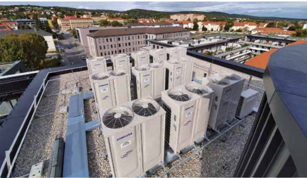
Die elf DVM S Außengeräte von Samsung/Samcool liefern bei Bedarf eine Gesamtkühlleistung von 439,40 kW. Zwei kleinere Außengeräte dienen zur Serverkühlung.
